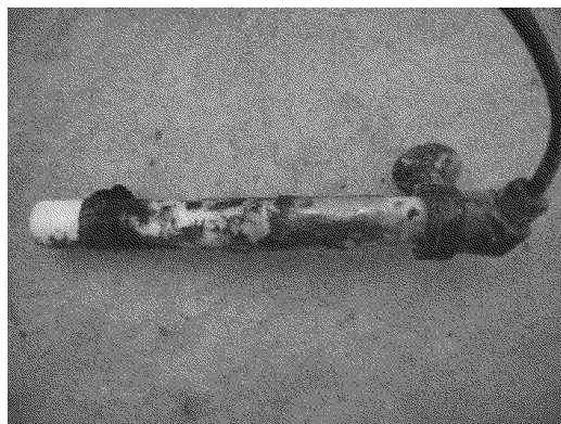
写真4 焼損したヒータの状況
